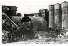
Abbruch Schweierei 1963.jpg
