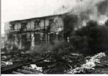
Abbruch Raffinerie 1963.jpg
