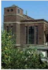
01 Abriss vom Kesselhaus Winter 2007
