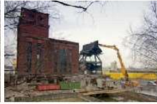
07-11-21 Abriss vom Kesselhaus
