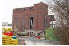
07-11-20 Abriss vom Kesselhaus
