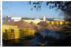
08-02-07 Abriss vom Kesselhaus
