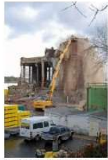
07-11-26 Abriss vom Kesselhaus
