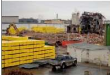
07-11-30 Abriss vom Kesselhaus
