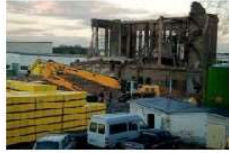
07-11-26 Abriss vom Kesselhaus
