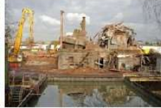
07-11-27 Abriss vom Kesselhaus
