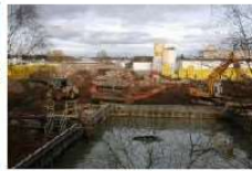
08-01-15 Abriss vom Kesselhaus
