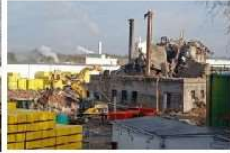
07-11-28 Abriss vom Kesselhaus
