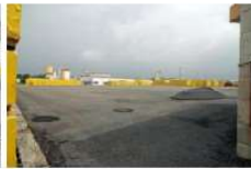
08-05-31 Abriss vom Kesselhaus
