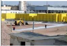
08-04-01 Abriss vom Kesselhaus
