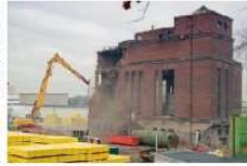
07-11-22 Abriss vom Kesselhaus
