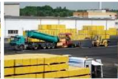
08-05-28 Abriss vom Kesselhaus
