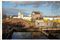
07-12-03 Abriss vom Kesselhaus
