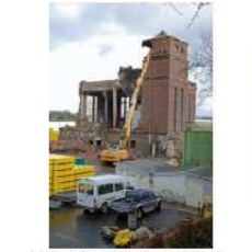
07-11-26 Abriss vom Kesselhaus
