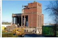
07-11-24 Abriss vom Kesselhaus
