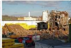
07-12-03 Abriss vom Kesselhaus
