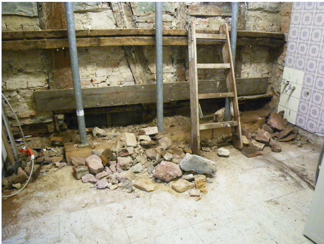
(Abb. 3: Austausch eines Schwellbalkens in der Küche)
